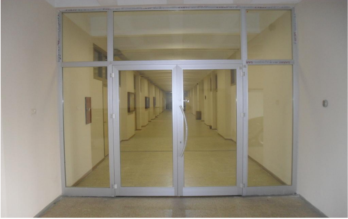
Ayazağa Yerleşkesi Merkezi Motorlar Binası MA 13 Mafsalı
