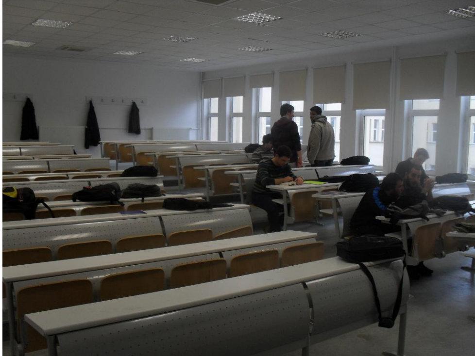
Ayazağa Yerleşkesi Elektrik Elektronik Fakültesi 5200 nolu sınıfların onarımı
