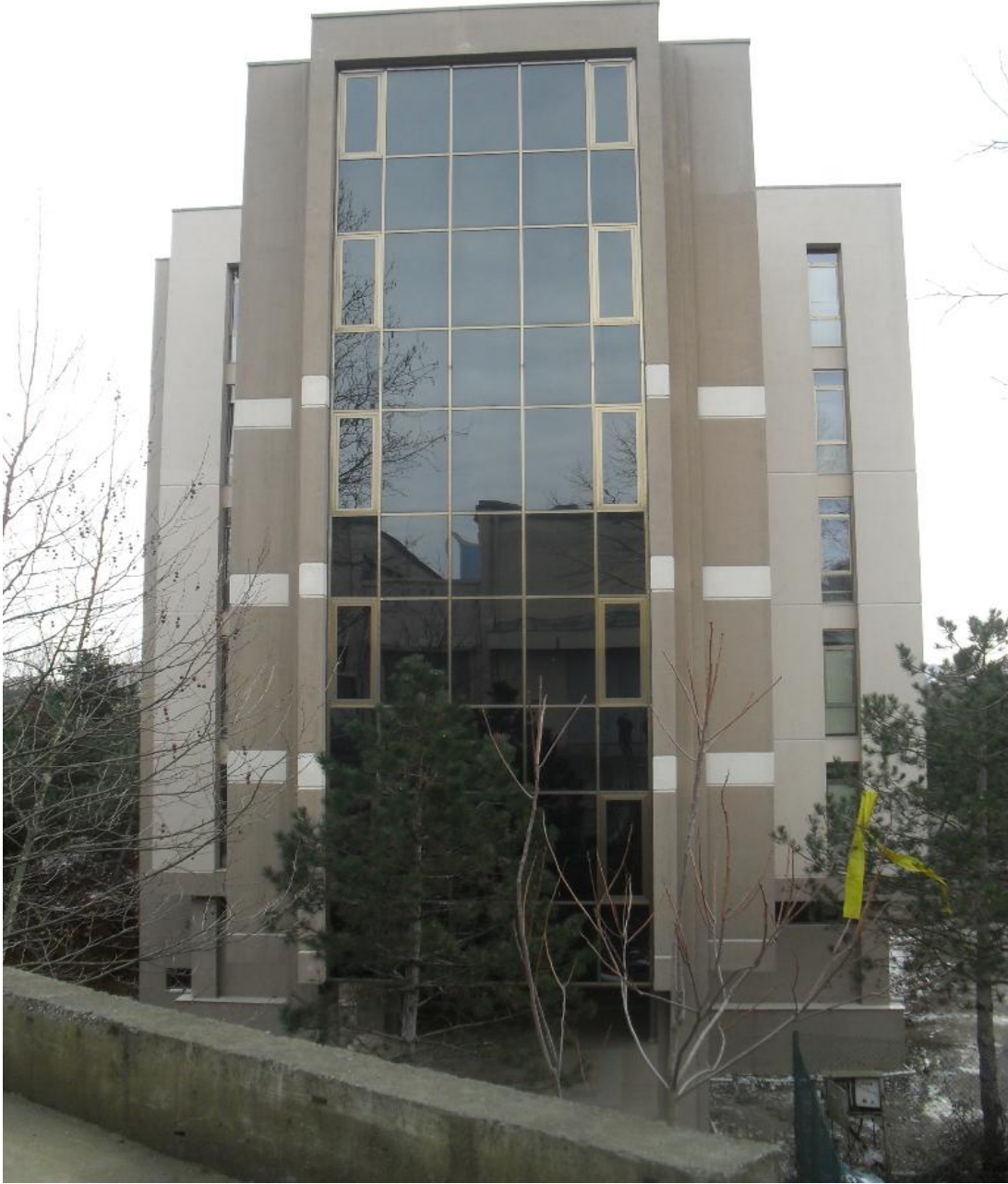
Öğretim Üyesi Yetiştirecek Yurt Binası İnşaatı
