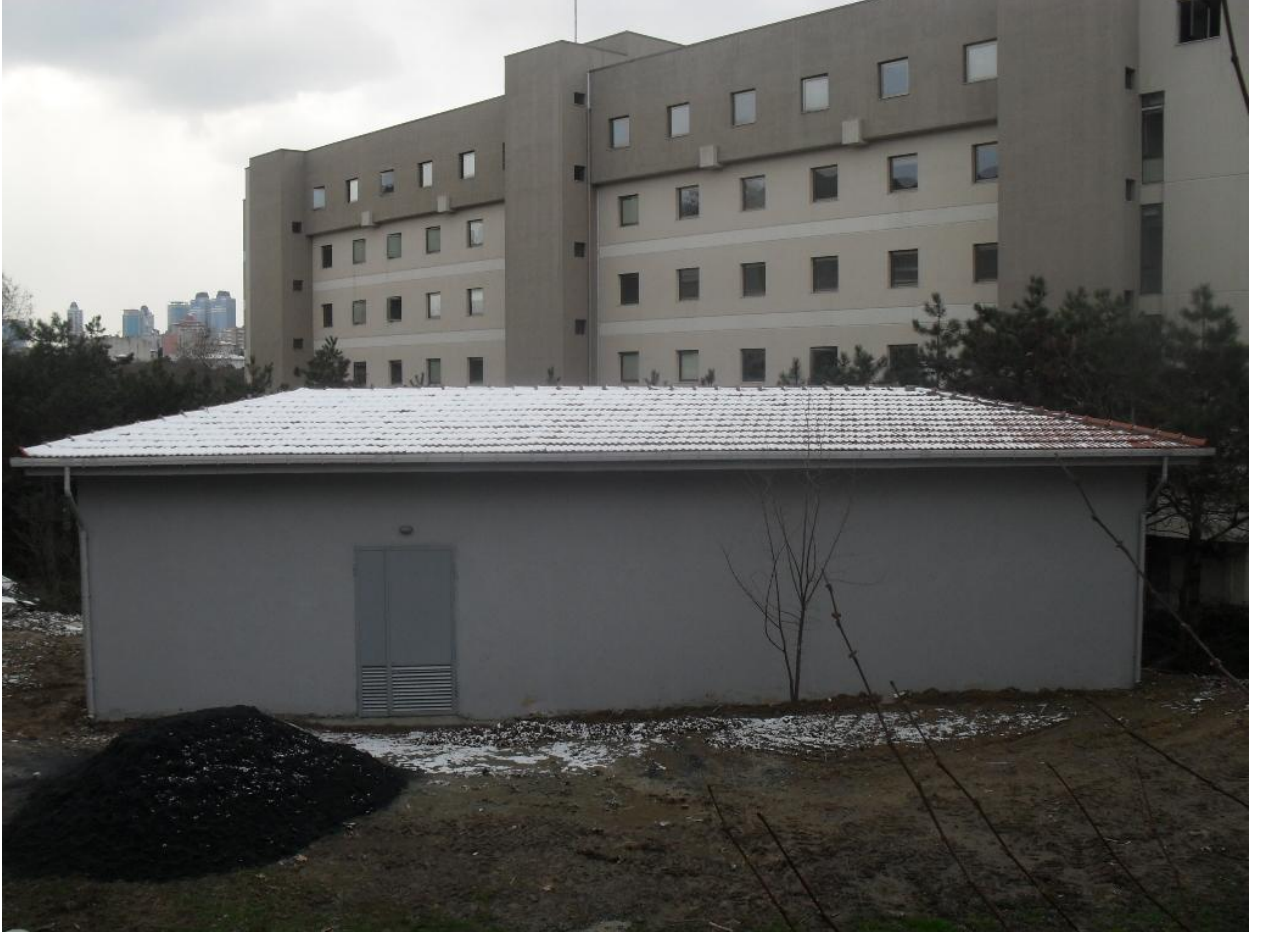
Ayaza Yerleşkesi 34,5 kv orta gerilim kablo hatları ve trafo dağıtım merkezi
