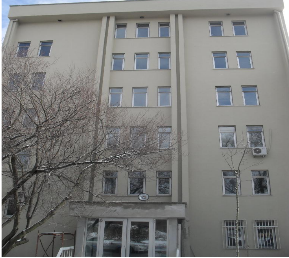
Ayazağa Yerleşkesi Gemi İnşaat ve Deniz Bilimleri Fakültesi Dış Cephe Boya ve Korozyon Onarım Tadilatı
