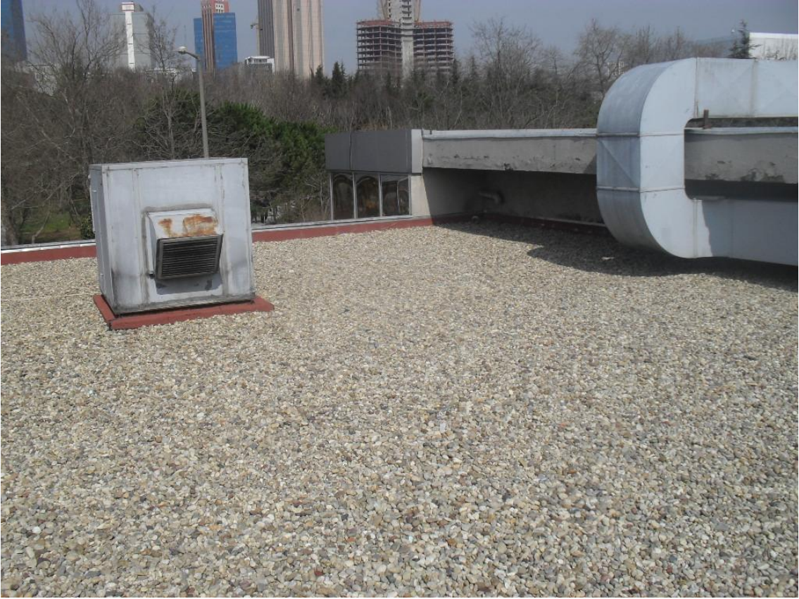
Ayazağa Yerleşkesi Merkezi Maden Fakültesi ile 75.Öğrenci Sosyal Merkezi Binaları Çatı Onarımı Maden fakültesi ile 75. Sosyal Merkezi Çatı Onarımı
