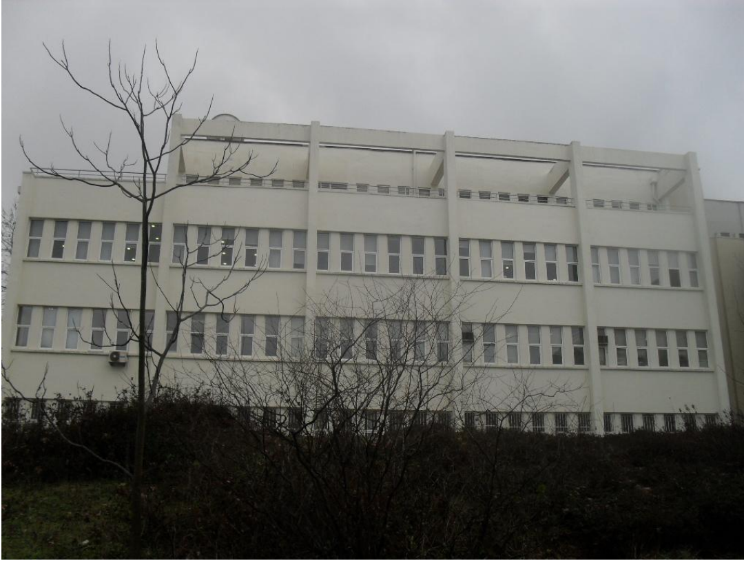
Ayazağa Yerleşkesi Elektrik Elektronik Fakültesi dış cephe boya ve korozyon onarımı
